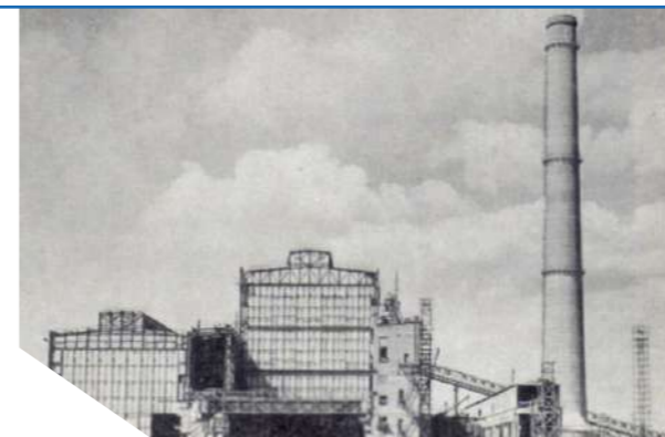
Budowa elektrowni Skawina
