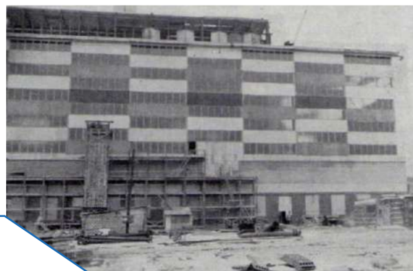
Budowa elektrowni Łagisza
