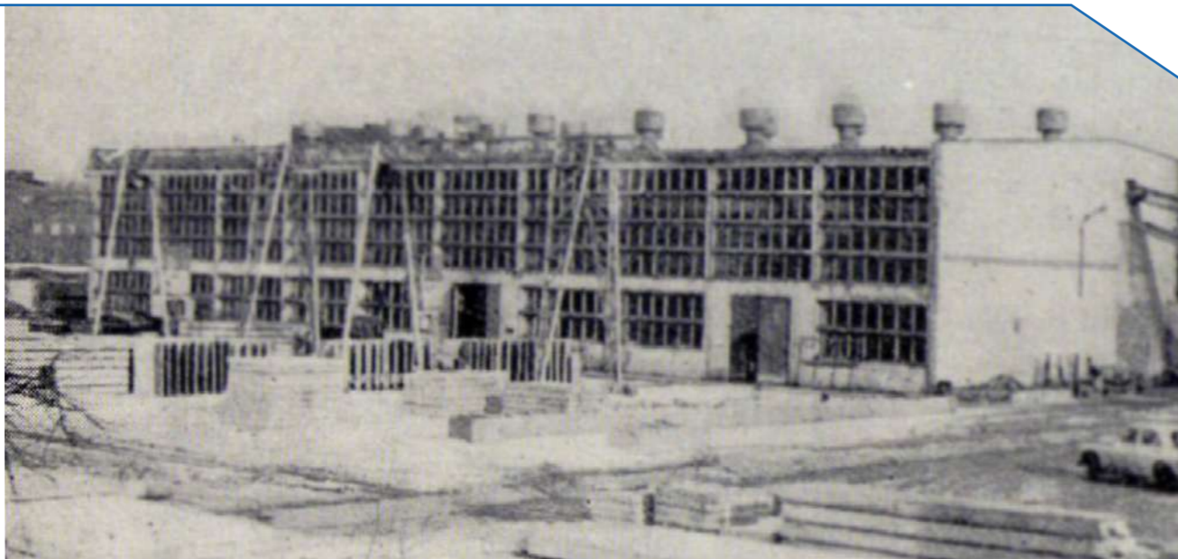
Zakład prefabrykacji, Kraków-Zabłocie
