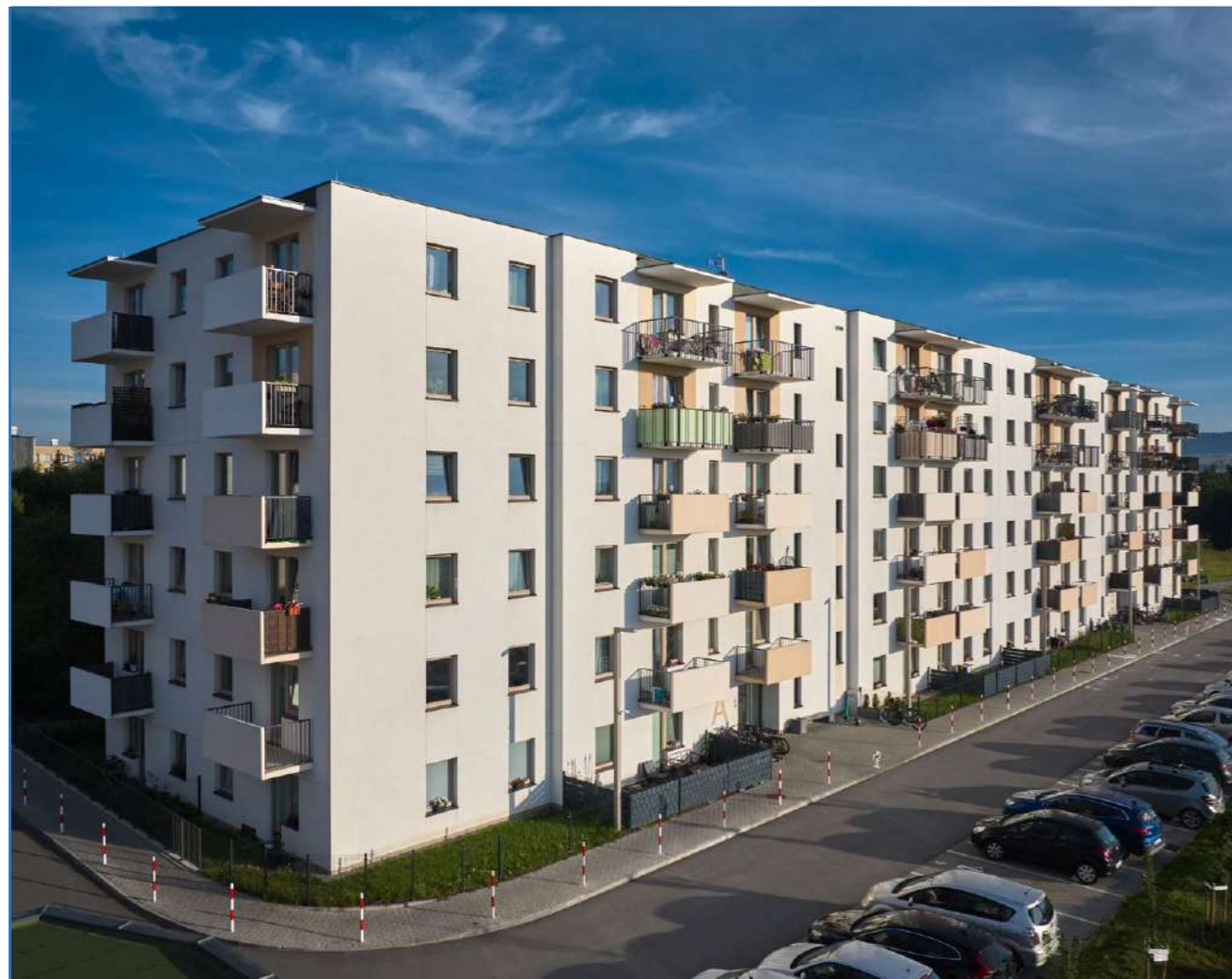
Budynek mieszkalny w Nowym Targu dla MDR Nowy Targ
