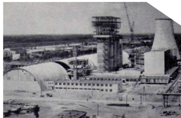
Budowa zakładów azotowych w Puławach
